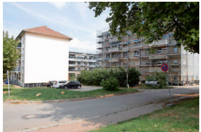
Die Rohbauarbeiten an den acht neuen Wohngebäuden im Quartier 5 sind abgeschlossen. Dann sollen im kommenden Jahr die 108 Wohnungen fertiggestellt und bezogen werden.
